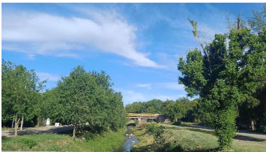
Foto 10. Arroyo Saldan y puente sobre la Ruta Intermunicipal (Av. Oscar Cruzado)
